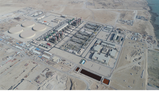
カタール Umm Al Houl Power
